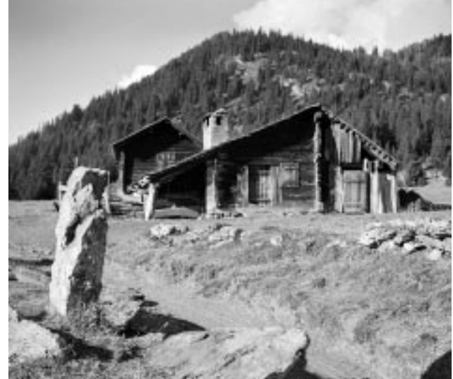
Les mayens: des bâtisses modestes, faites d'une élévation en bois posée sur des fondations en pierre.
