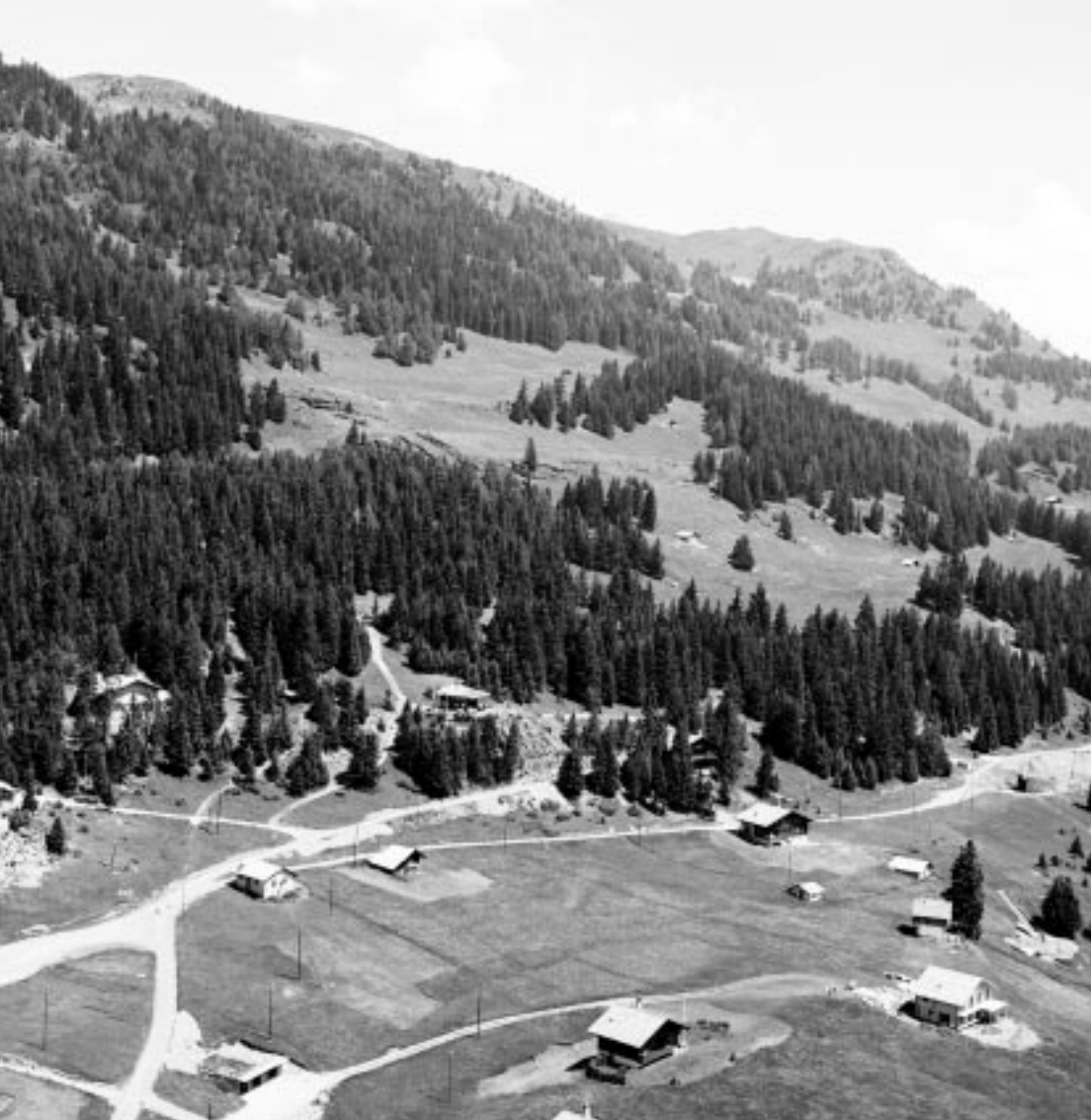
La chaîne du Mont- Lachaux est traversée par le tunnel qui aboutit à Plans-Mayens. Vue aérienne. Vers 1960.
